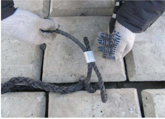
Два ДМК соседних ГБ-плит продеваются в обжимную втулку. Втулка располагается максимально близко к выходу ДМК из бетонного блока.
