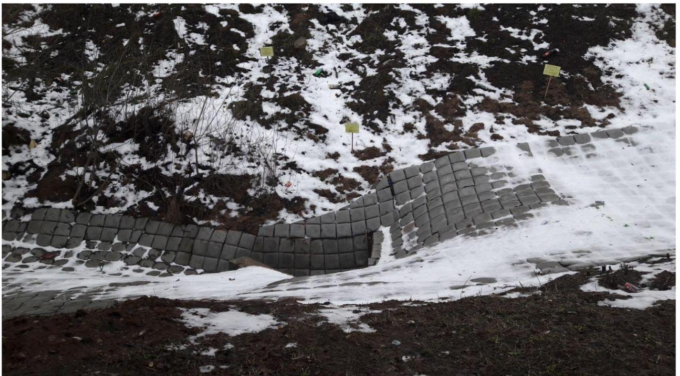
Рисунок Г.4 - Водоотвод
