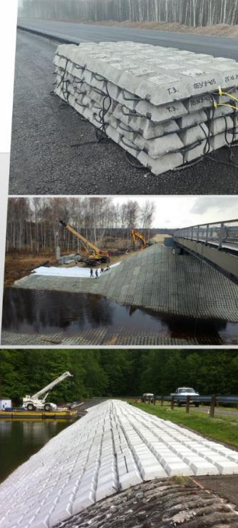
**УСЛОВНАЯ СХЕМА ПРИМЕНЕНИЯ ГИБКОГО БЕТОННОГО ПОКРЫТИЯ**
