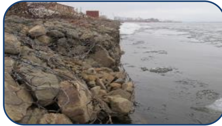
путем применения габионных конструкций
