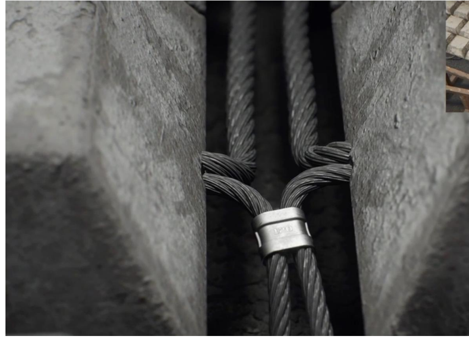
наличие замоноличенных дополнительных монтажных канатов, которые фиксируются при помощи алюминиевой втулки
