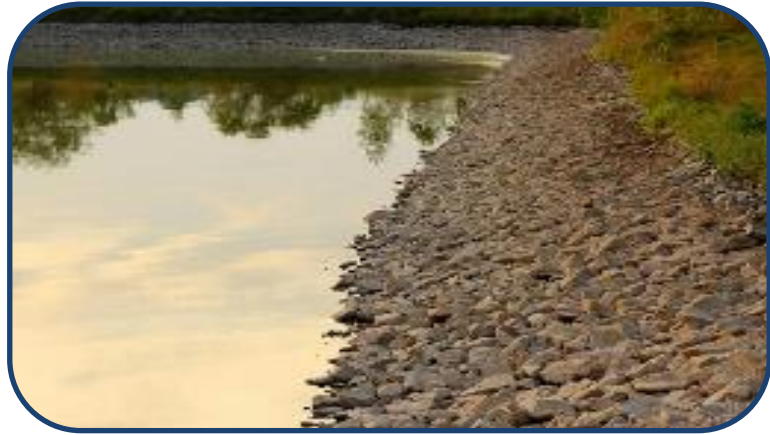
путем отсыпки (наброски) камнем
