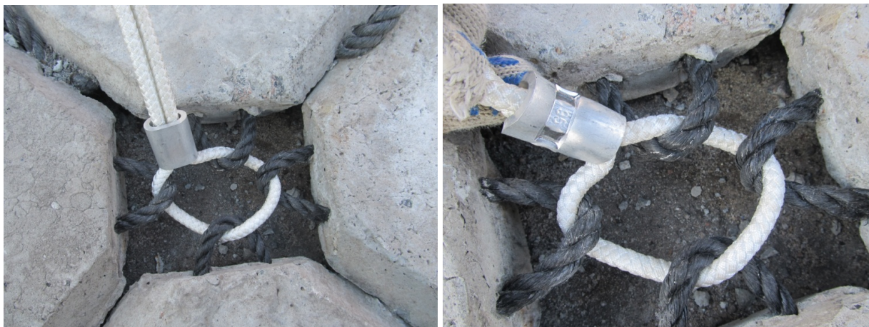
Рис. 4. Соединение ПБЗГУ за угловые петли
