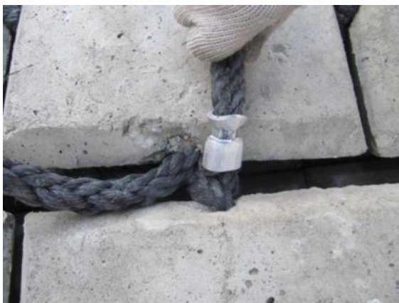
Рисунок 4.5 – Скрепление ГБ-плит за ДМК обжимной втулкой
