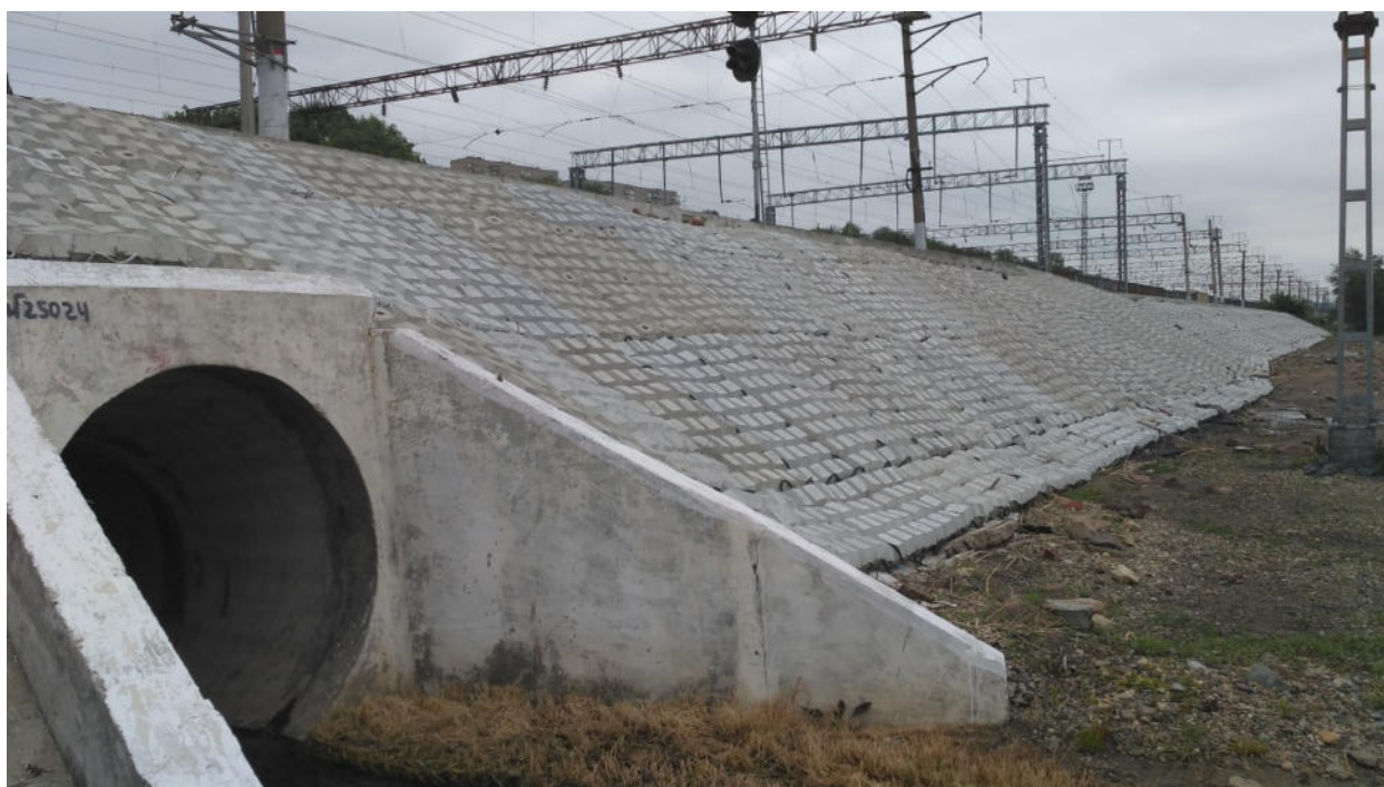
Рисунок Г.5 - Водоотвод
