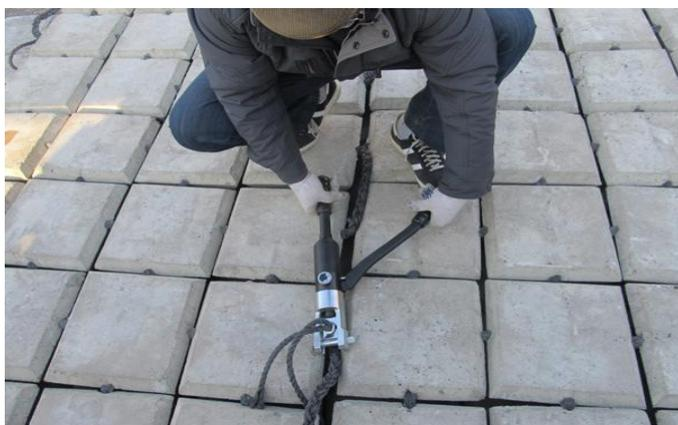
**Фото 12. Скрепление ГБК путем обжима кольца, надетого за крепежные концы**
