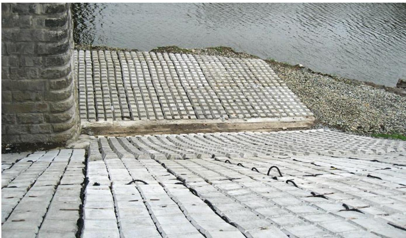
**Фото 10. Чередования верной и не правильной ориентации ГБМ или ГБК при укладке**
