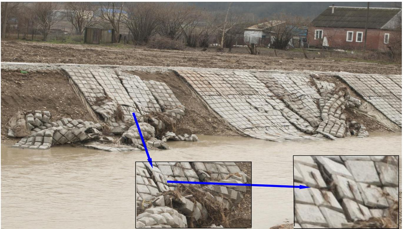
**Фото 15. Разрушение защитного покрытия, собранного с нарушением технологии крепления ГБК между собой**
