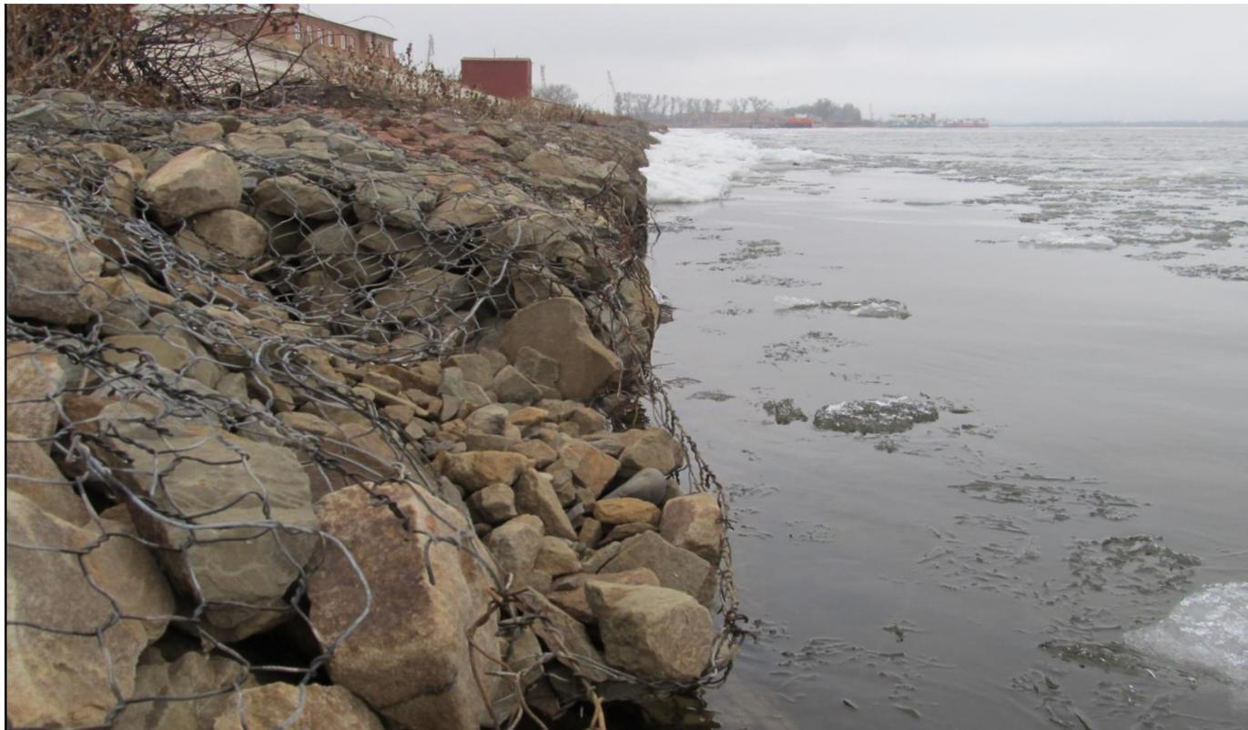
**Фото 19. Повреждение габионов, выполняющих функции крепления нижнего упора**
