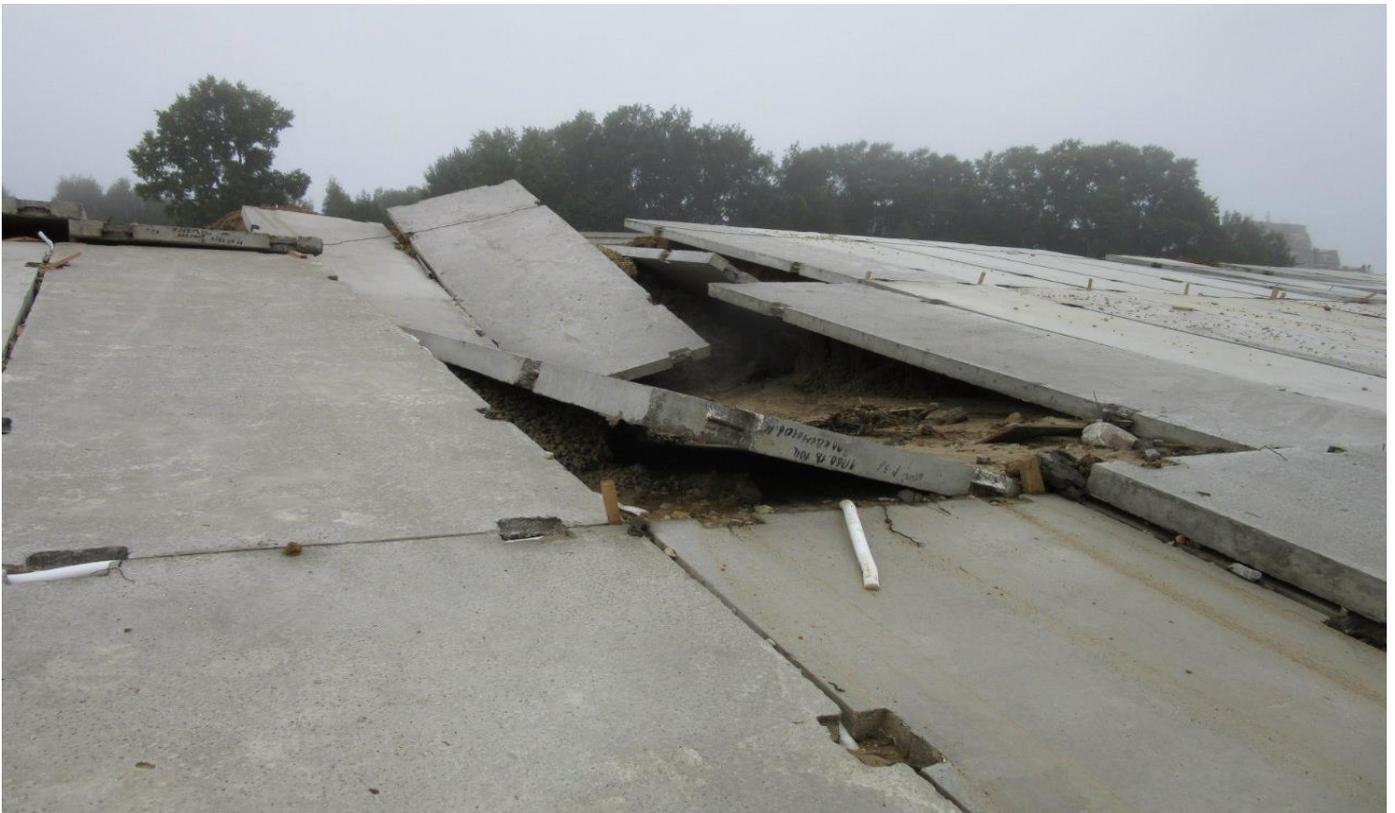
**Фото 22. Обрушение берегозащитного ГТС, построенного с применением СЖБК**
