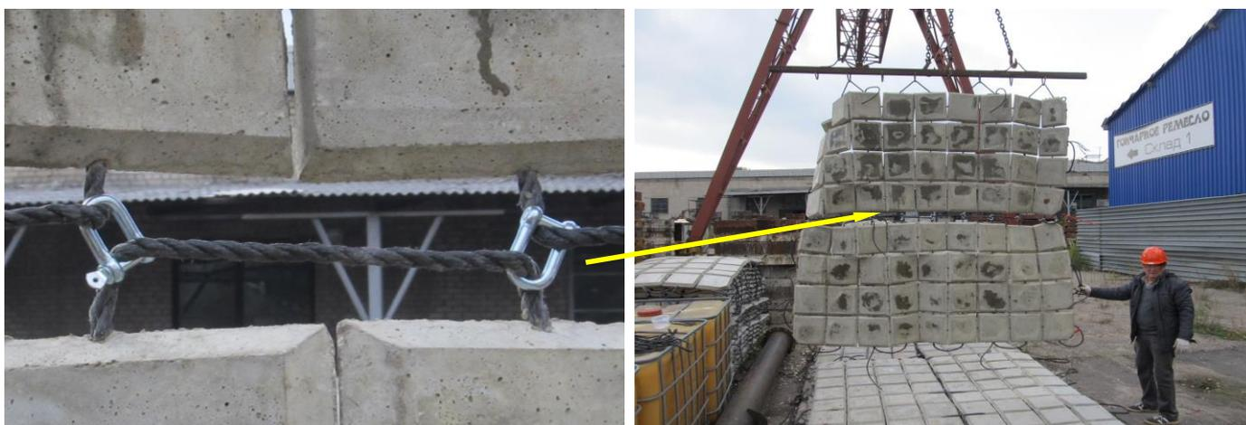
**Фото 7. Скрепление ГБМ или ГБК между собой скобами такелажными**
