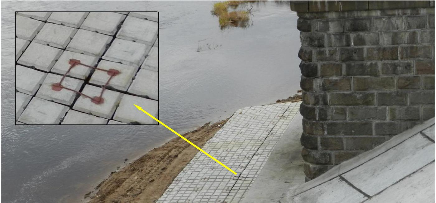
**Фото 14. Скрепление ГБК методом сварки**
