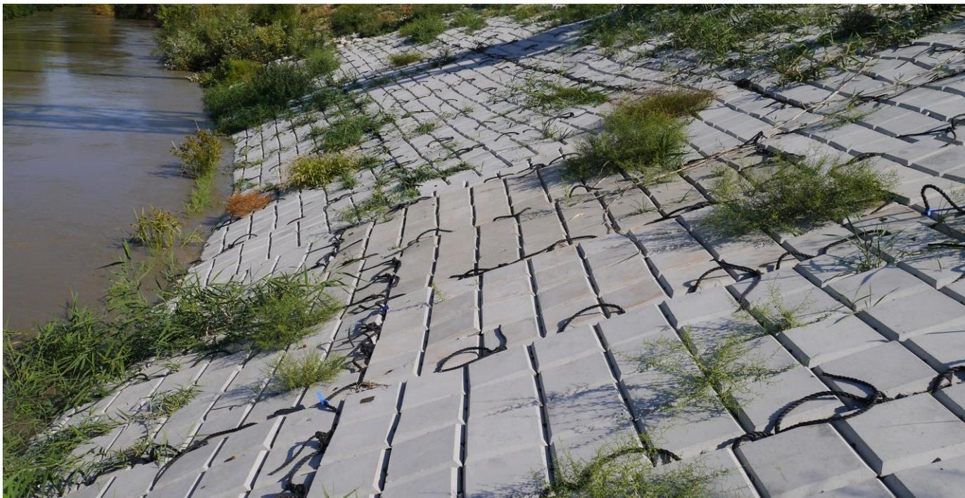
**Фото 3. Гибкое бетонное покрытие (ГБП) с торчащими такелажными (строповочными, монтажными) петлями**
