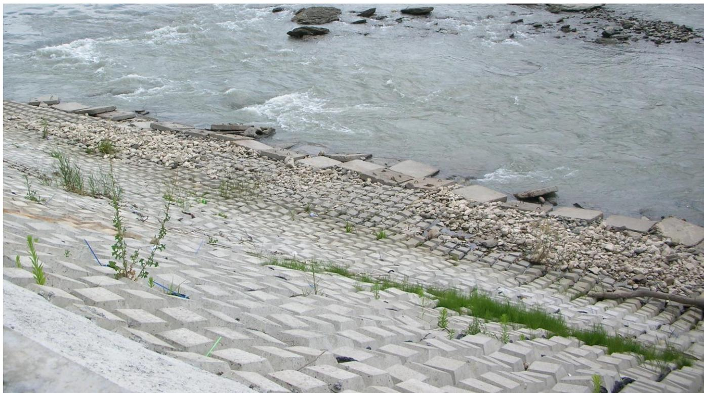
**Фото 5. Закрепление ГБОП на склоне "методом подвешивания" и разрушение нижнего упора**
