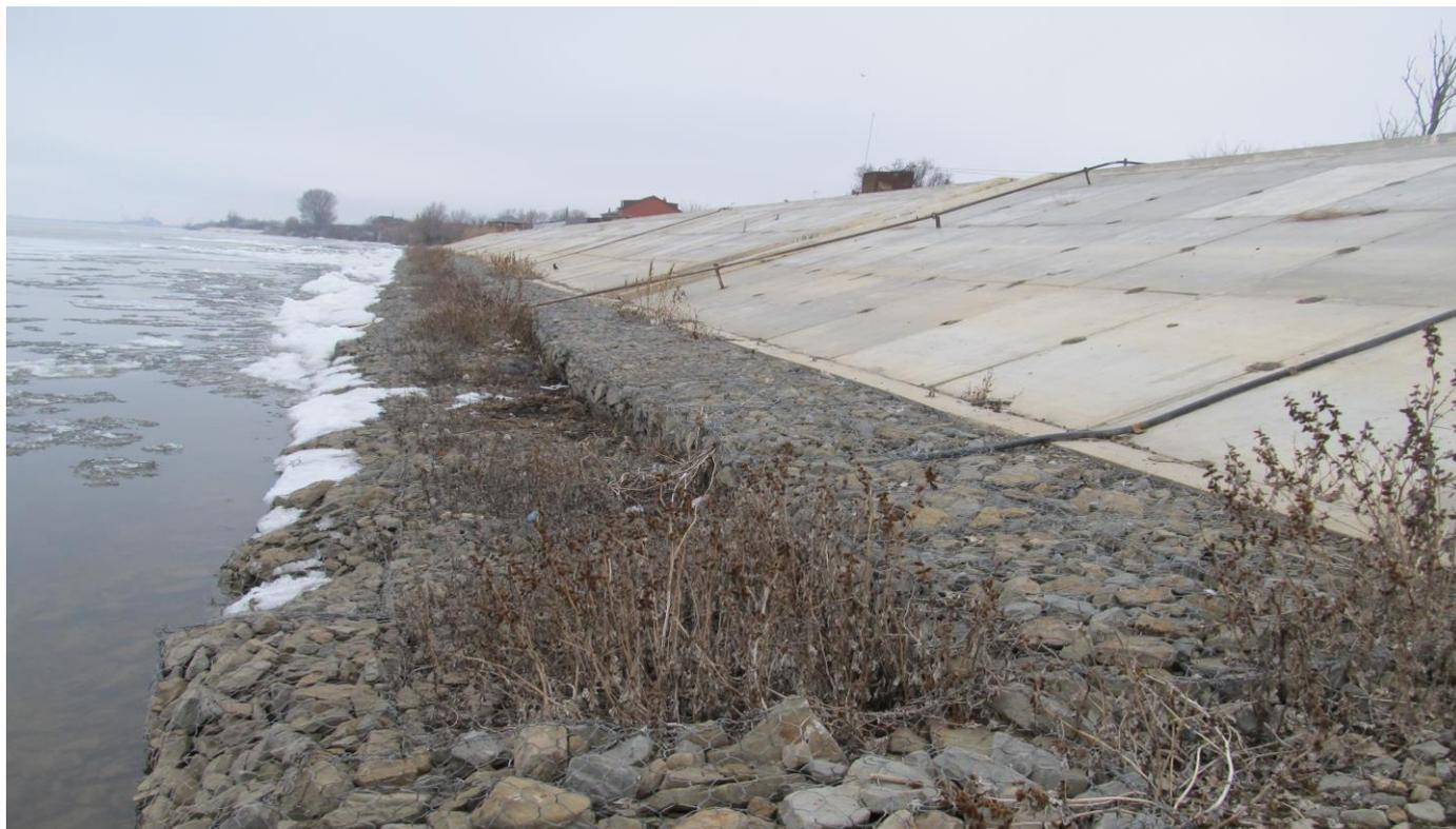
**Фото 17. Нижний упор берегозащитного ГТС, закрепленный габионами**
