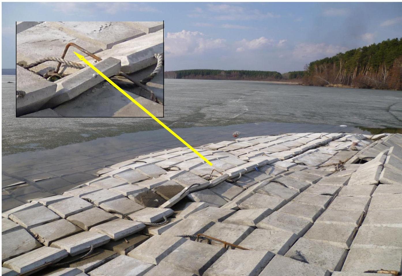
**Фото 4. Скрепление отдельных ГБМ или ГБК между собой с использованием П-образных скоб**
