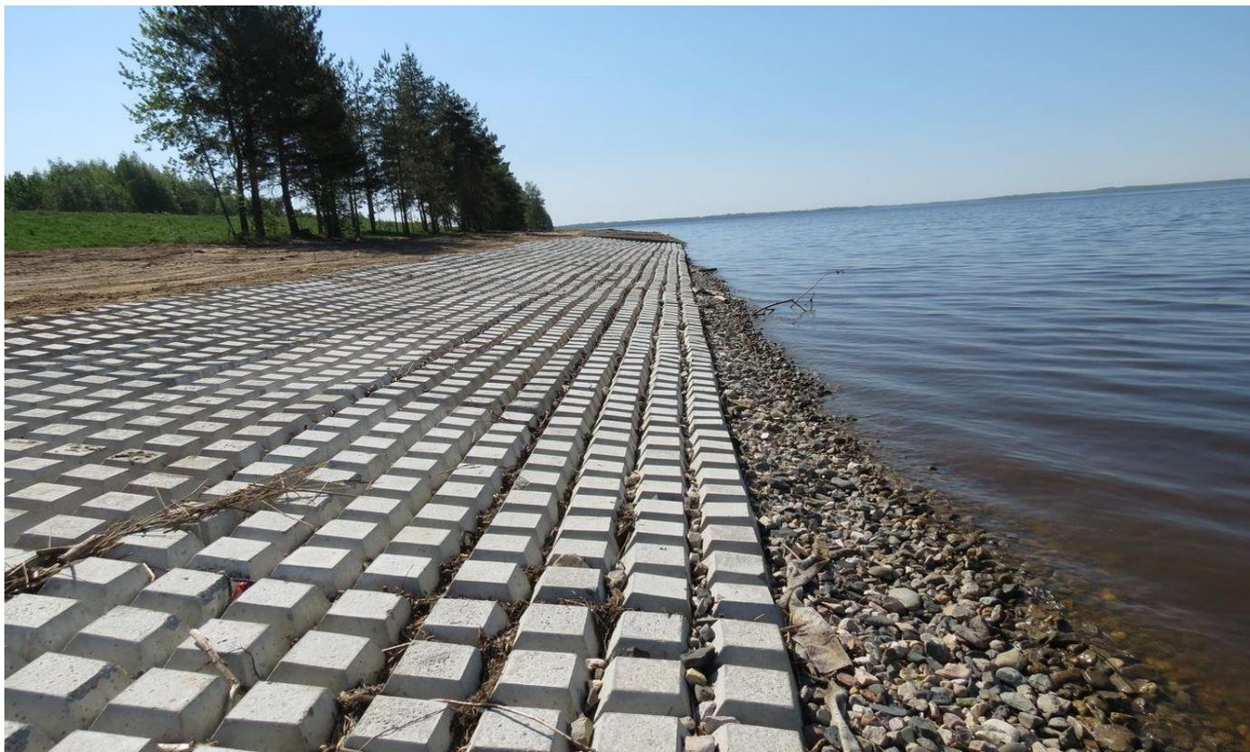
**Фото 8. Использование в качестве противосуффозионного элемента гальки, щебня или камня**
