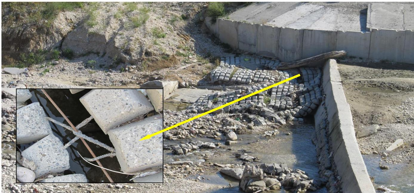
**Фото 6. Скрепление ГБМ или ГБК между собой за такелажные (строповочные, монтажные) петли**
