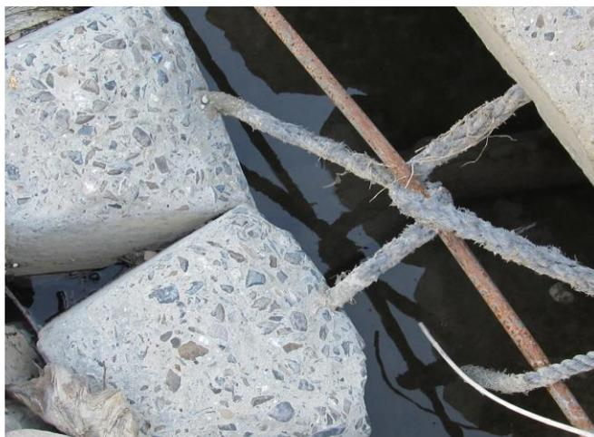
**Фото 9. Истираемость бетонных блоков в процессе эксплуатации**
