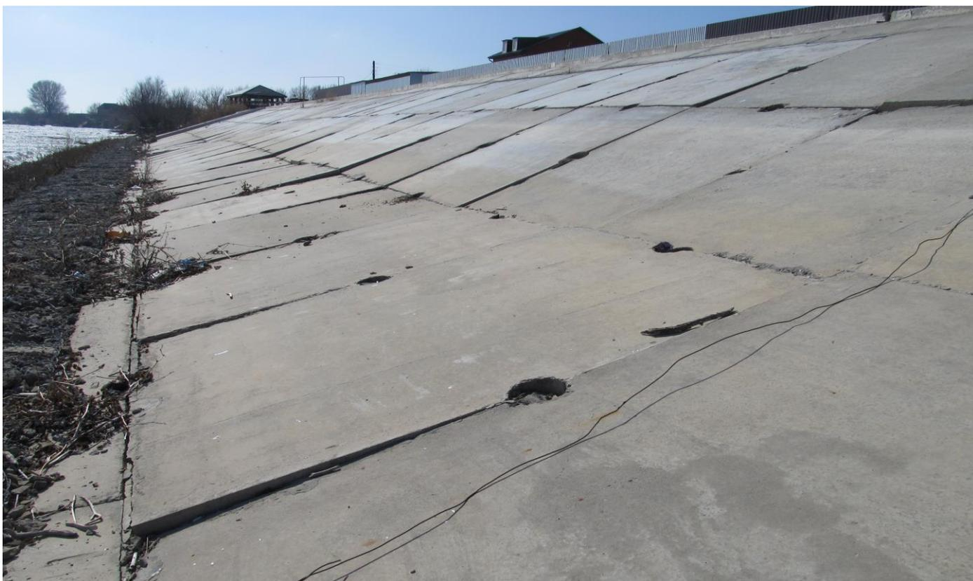
**Фото 21. Перемещение СЖБК в вертикальной плоскости (проседание)**
