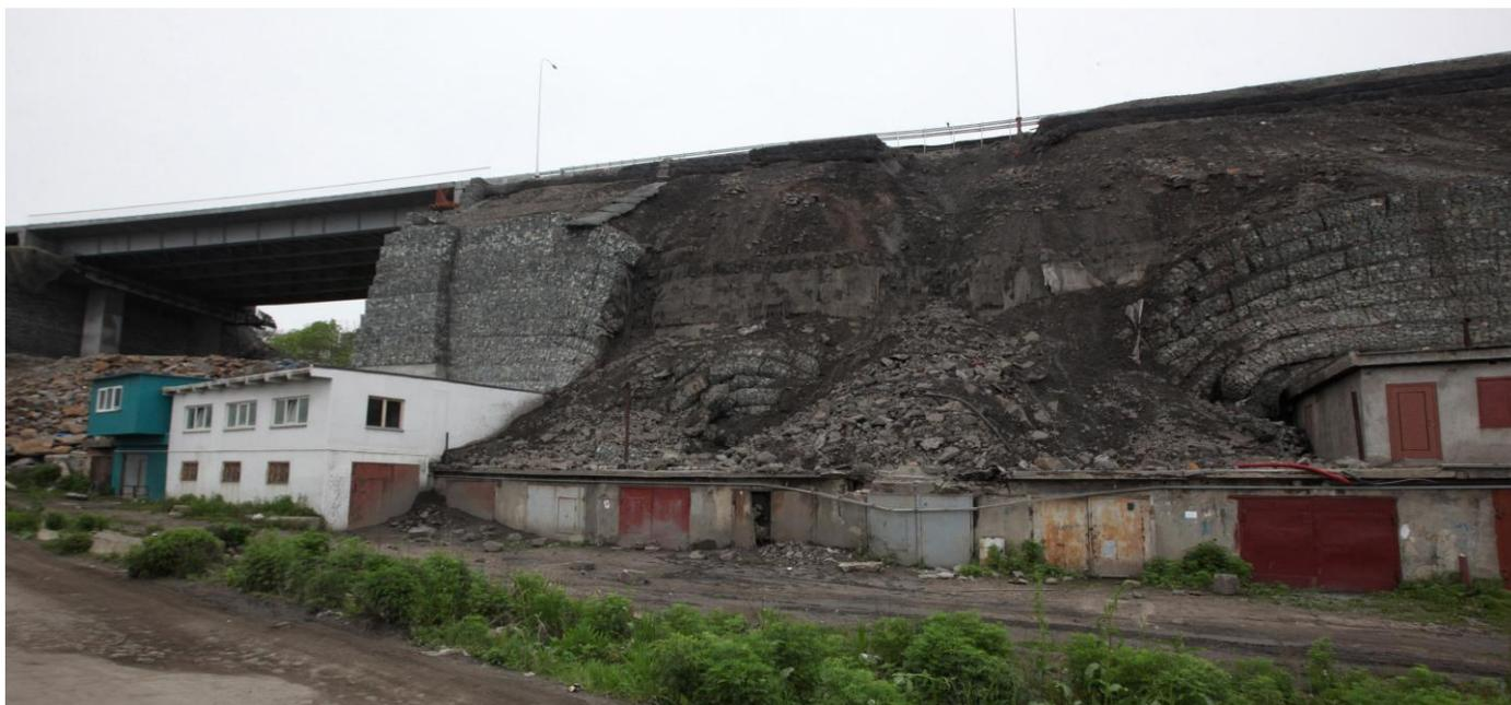
***Фото 25. Обрушение подпорной стены, выполненной из габионов***
