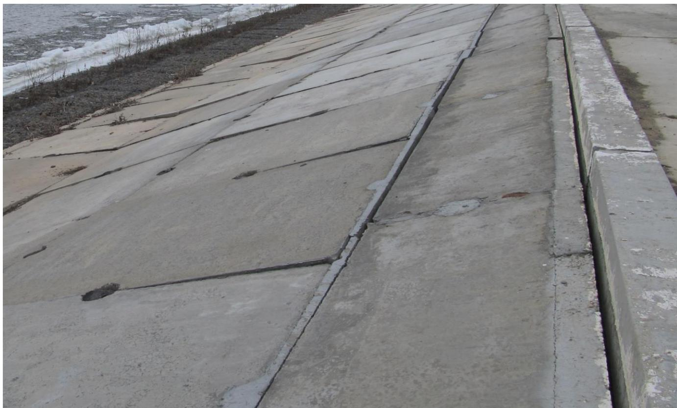
**Фото 20. Образование щели (зазора) между верхним упором и СЖБК**
