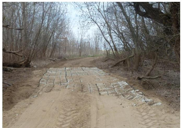
Для обустройства переезда через топкое место перед началом паводка с помощью бульдозера устраняется дорожная колея. Другой подготовки грунтовой дороги не требуется.
